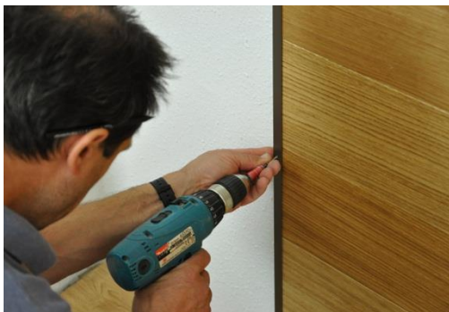
18. Az alumínium takaróprofil felhelyezése
