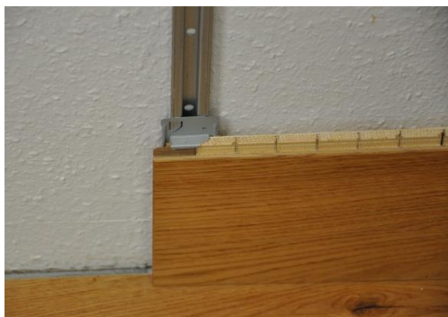
11. Fixált rögzítőkapcsok A további szerelés során használja a parketta szerelőkapcsait az elemek hornyolt oldali rögzítéséhez. Ekkor a kapocs egyszerűen befördíthető a rögzítőcsínbe, és a hornyon lefelé tolható.
