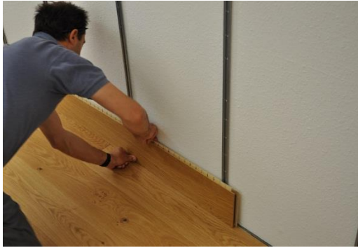
7. A kezdőkapcsok elhelyezését követően a lemezek egyszerűen bepattinthatók a rögzítőcsínekbe.
