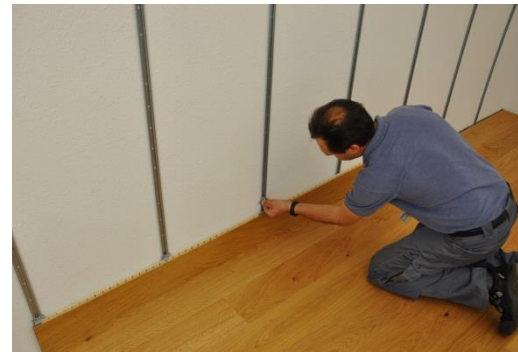
12. Helyezzen minden rögzítőcsínre rögzítőkapcsot
