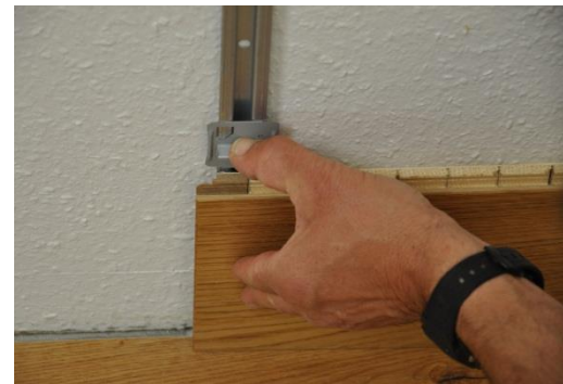
10. A rögzítőkapcsot tolja lefelé a csatlakozásig
